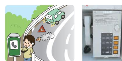
※1 主道上每1km设置一个，隧道内每200m设置一个。只摘下听筒即可接通道路管制中心。使用设有事故、故障、救急、火灾情况的表示按键的紧急电话时，请根据情况按下符合的按键。
