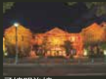
函馆明治馆 (旧函馆市邮政局) ①
